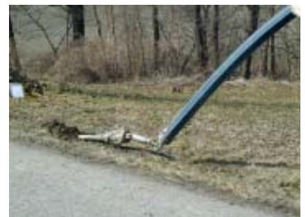
Wie ein Maulwurf hat sich das Bohrgerät durch den Boden gefräst. Hier wird die Druckleitung auf dem Rückweg der Bohrung eingezogen. Durch dieses Verfahren konnten erhebliche Geldmittel und vor allem auch Zeit eingespart werden, da mit Sommer dieses Jahres die gesamte Baumaßnahme abgeschlossen werden soll.
